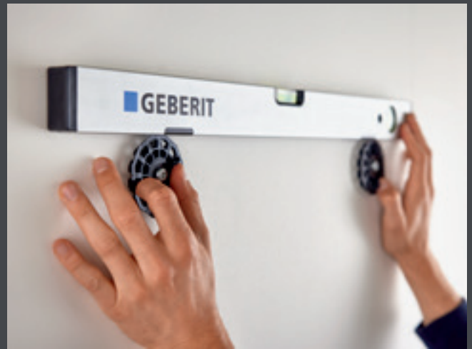
↑ Tarkista suoruus, korkeus säädettävissä enintään 5 mm.
