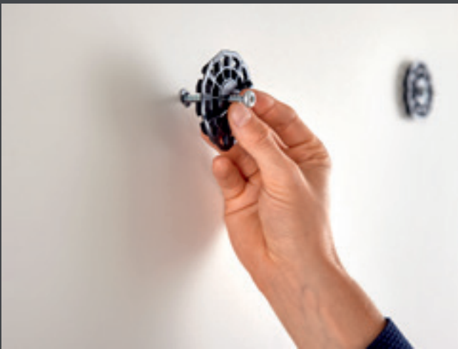
↑ Kiinnitä Geberitin seinäkiinnityspidike.
