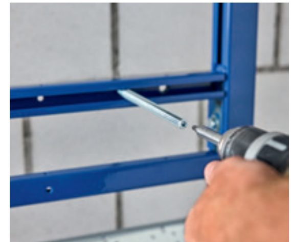
↑ Kierretangot on varustettu syvävetokierteillä, joten ne voidaan ruuvata haluttuun pituuteen ilman, että niitä tarvitsee leikata. Voit käyttää myös siirrettäviä T-ura-mutteria.
