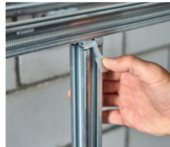
↑ Työkaluvapaa asennus siirrettävillä kiinnikkeillä.
