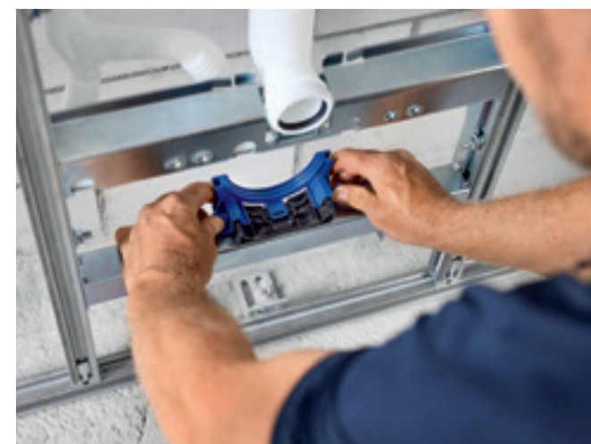
← Älykkäät asennusratkaisut, kuten syvyysäädetävät putkikiinnikkeet, helpottavat mitatoleranssien kompensointia.
