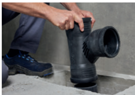
Geberit Silent-Pro SuperTube -yhteet liitetään muhviiliitoksiin.
